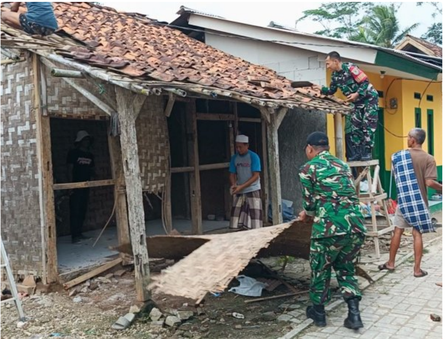
Pembongkaran Rumah Bapak Narmin
